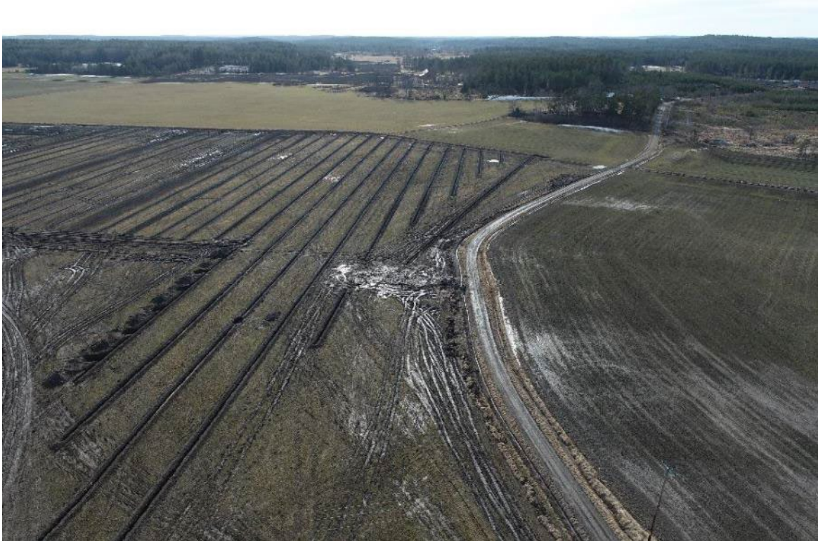
Anläggande av filterdiken vid Loftaån.
